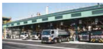
四国事業所 陸上出荷設備
